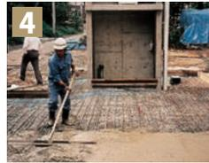
ヒーティングパイプの上からコンクリート(アスファルトでも可)7~10cm程度かぶせませす。(参考:歩道は約7cm・駐車場は約10cm)機密テスト、試運転、及び各種調整を行ない、工事完了です。
