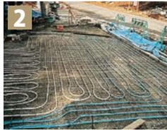
架橋ポリエチレン(またはナイロン)のヒーティングパイプを敷設し、ヘッダーに接続します。エア抜きをしながら不凍液\*を注入します。
