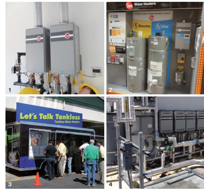
1 新築物件に納入したFF式給湯器。アメリカは屋内設置が多い 2 量販店でのリム展示ブース。電気やガスを利用した給湯器も扱う 3 タンクレス給湯器の普及に向けたデモカー 4 商業用施設に納入した連結式の給湯器
