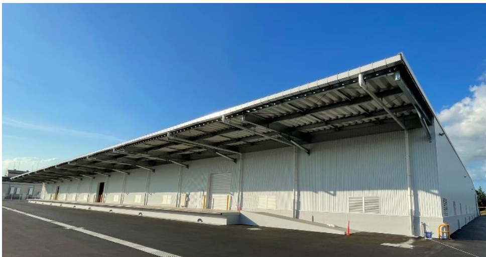
(株)パロマ 東日本ロジスティクスセンター
